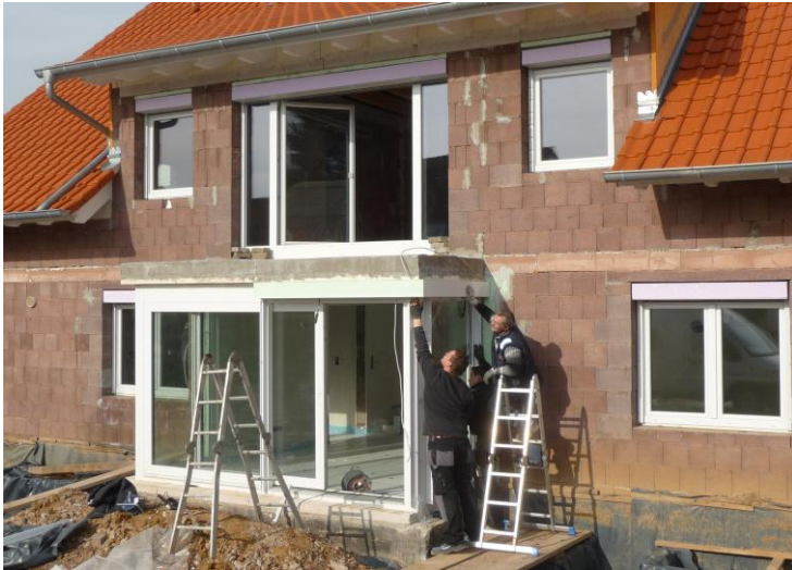
Neubau montage Fenster- und Fenstertürelemente
